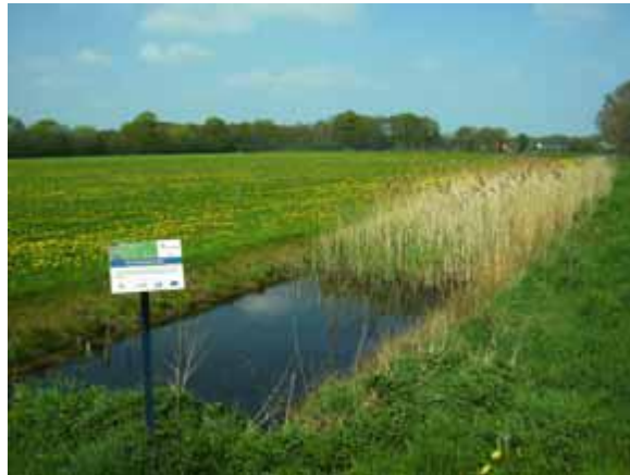
Helofytenfilter bij watervoerende watergangen / sloten (Vb: Zandwetering in Gooiersmars bij Deventer (Waterschap Groot Salland))
